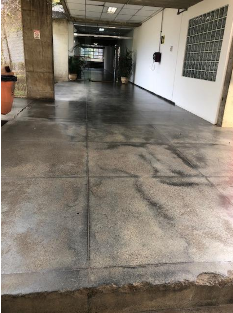
Foto 2: Piso e rodapé em granilite a serem demolidos
