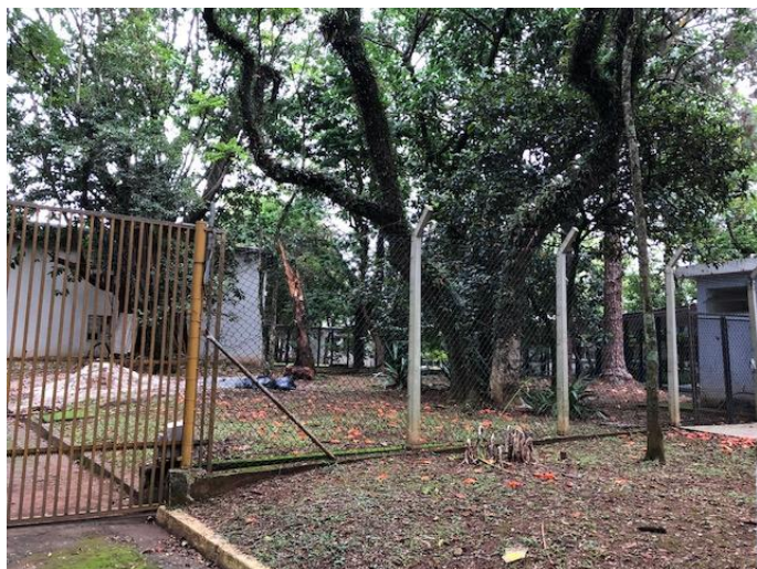
Foto 2: Trecho de alambrado a ser removido para instalação de novo alambrado
