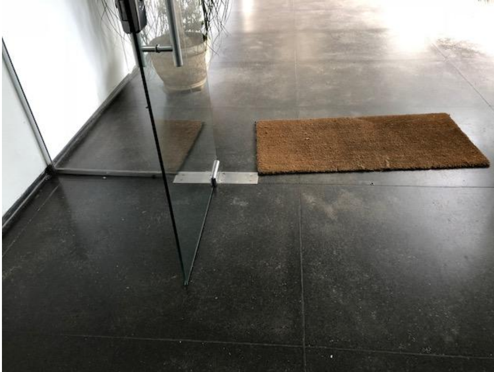
Foto 3: Porta de vidro a ser retirada e reinstalada
