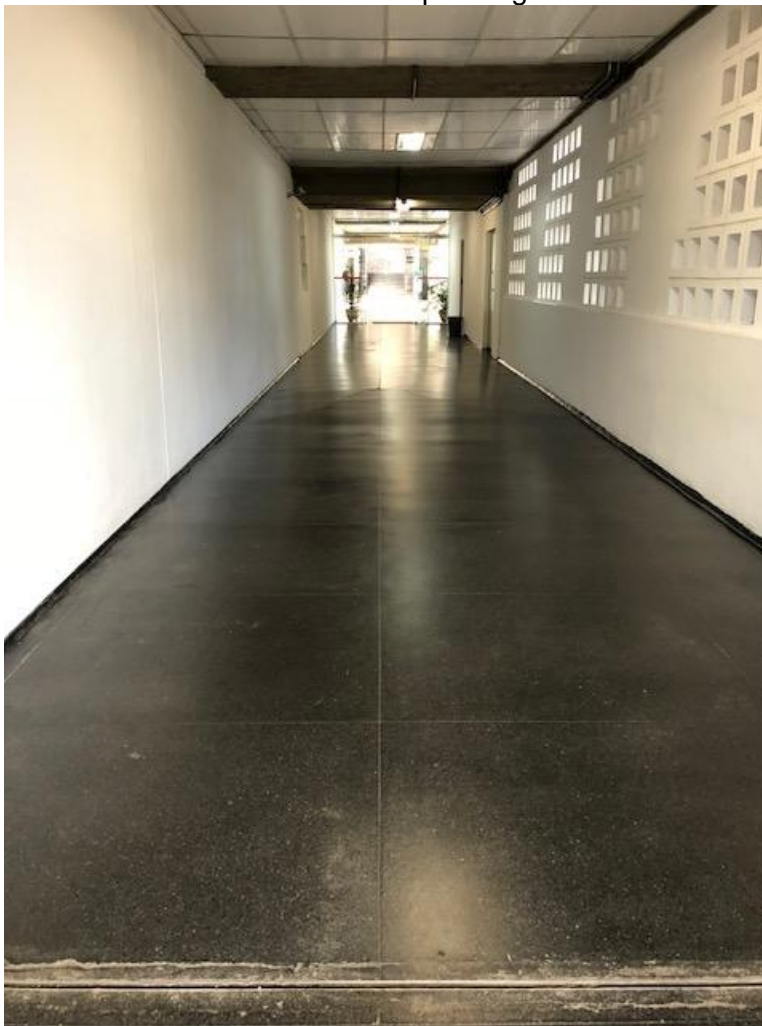
Foto 1: Piso e rodapé em granilite a serem demolidos
